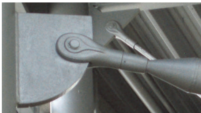
Compressiesysteem verbonden met een gelaste plaat
